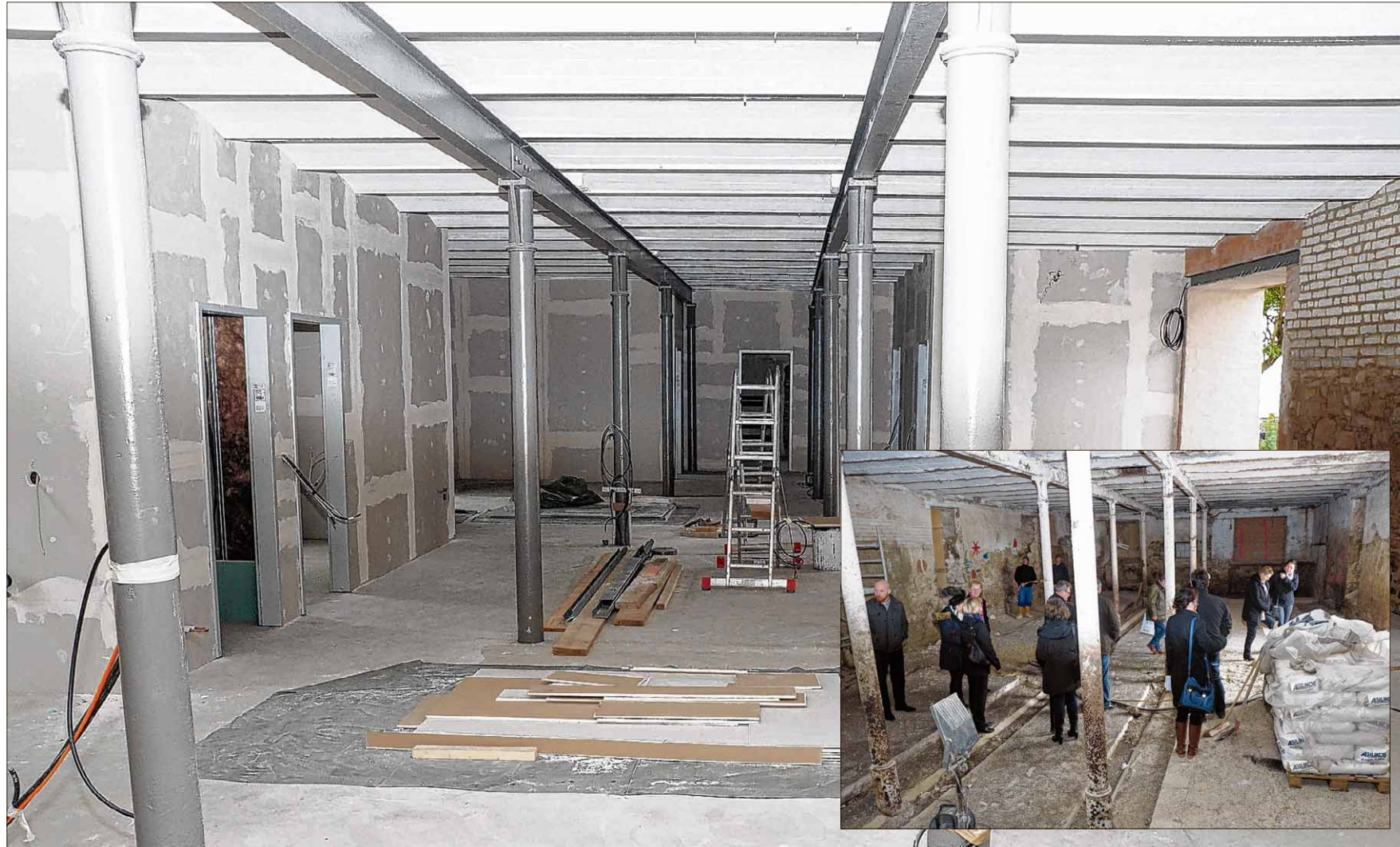
Gearbeitet wurde gestern nicht auf der Baustelle. Aber der Fortschritt im Dorfladen ist im Vergleich zum kleinen Foto, das im Februar entstand, schon deutlich erkennbar. Vorn befindet sich der Ladenraum, ganz hinten links zieht ein Friseur ein, und durch die Tür geradezu geht es in einen kleinen Versammlungsraum. Fotos (2): Mario Heinicke
