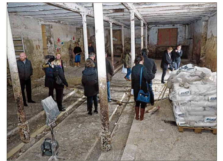
So sieht der künftige Dorfladenraum jetzt noch aus. Doch die Handwerker haben mit dem Innenausbau begonnen.
